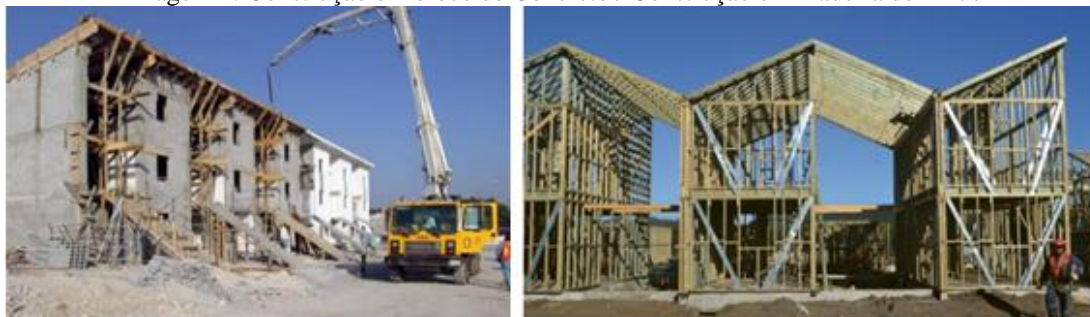
Imagem 4: Construção em bloco de Concreto / Construção em madeira de Pinus
